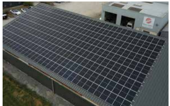
USINE LAFONT TRAVAUX PUBLICS À ORTHEZ (64) - PUISSANCE : 100 kWc
